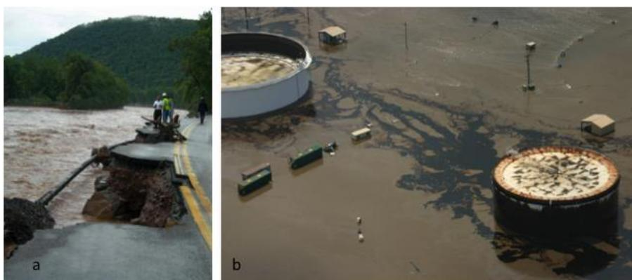
Figura 3. a) Danno a tubazioni durante l'alluvione del 2014 in Pennsylvania, USA [fonte: <https://dcbureau.org/tag/earthjustice>]; b) rilascio di idrocarburi in una raffineria in seguito a un'alluvione in Coffeyville (USA) nel 2007 [fonte: <http://ksview.org/info/news.shtml>].
