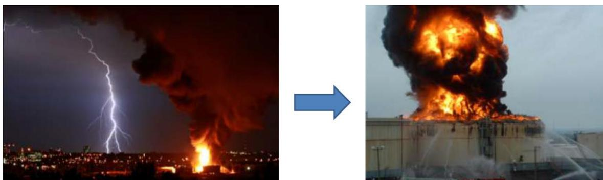
Figura 4. Incendio di un serbatoio di grezzo per fulminazione, 28 Agosto 2006 Whifessville (USA) [15]
