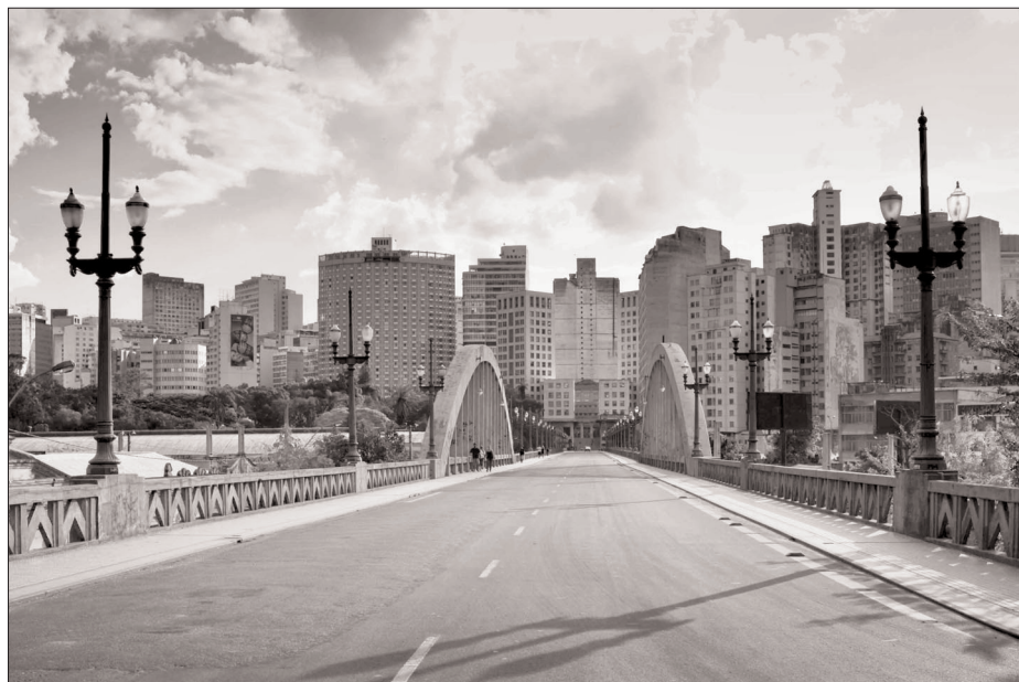
Fig. 2 – Il Viaduto Santa Tereza oggi
