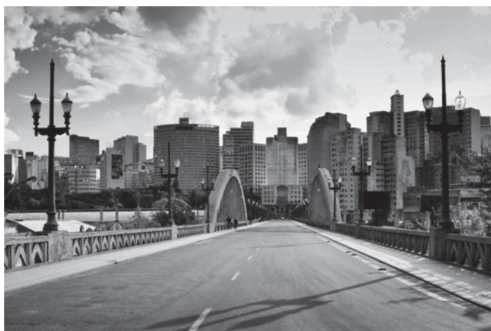
Fig. 2 – Il Viaduto Santa Tereza oggi.
