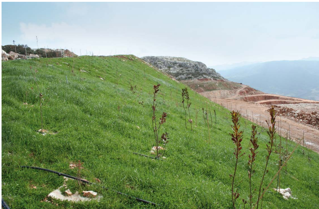
Figura 1. Panoramica del sito di intervento
