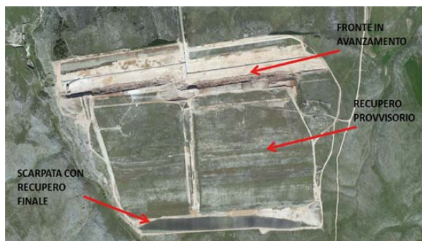
Matera – Cava Trasanello recupero provvisorio e definitivo
