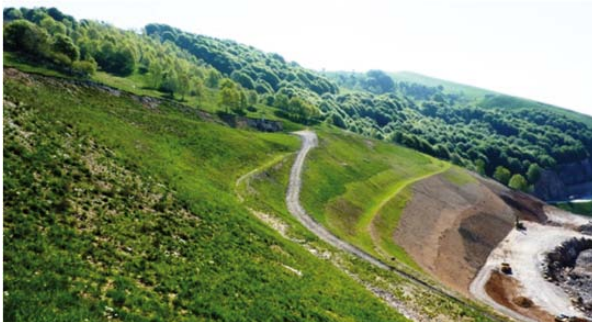
Esempi di recuperi contestuali alla coltivazione con scarpate a tesa unica
