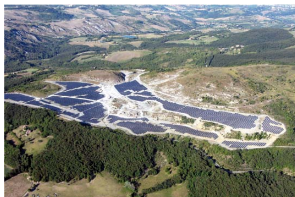
Impianto fotovoltaico miniera M.Montanara (MO)
