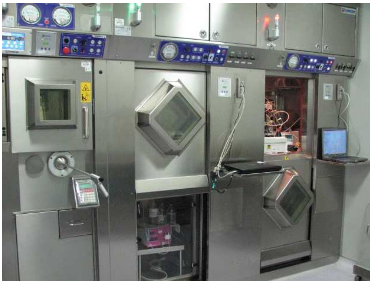
Fig. 36. Nuova Radiofarmacia- Interno del laboratorio di sintesi dei traccianti di ricerca marcati con Carbonio-11. Si individuano due celle di sintesi con, al loro interno, i moduli, e, sulla sinistra, il frazionatore di dose per l'arrivo del radiofarmaco, classificato in classe A.
