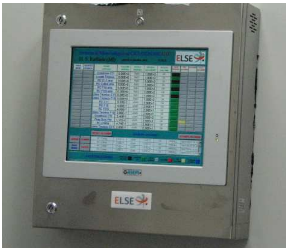
Fig. 37. Nuova Radiofarmacia - Sistema di monitoraggio ELSE, per il controllo delle contaminazioni ambientali dei locali.
