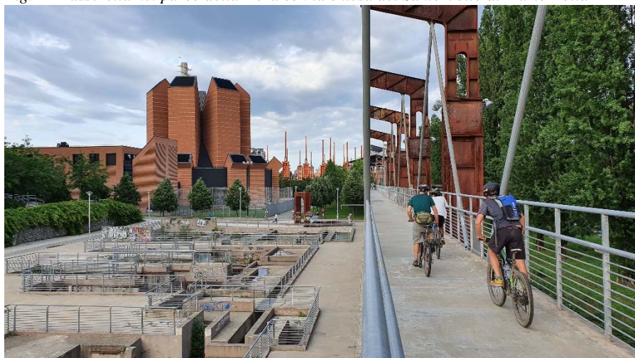
Fig. 2 - Passerella nel parco della Dora con la chiesa del Santo Volto di Mario Botta
